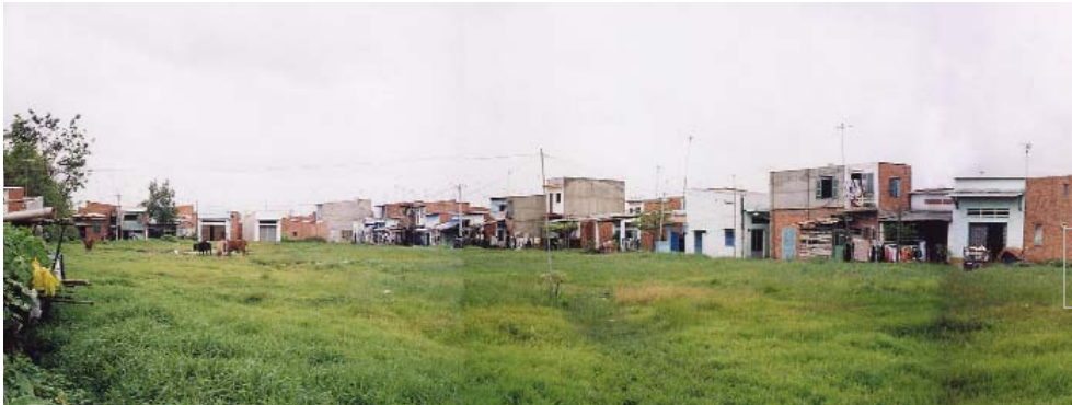
Vue du site de construction dans l'état actuel.
